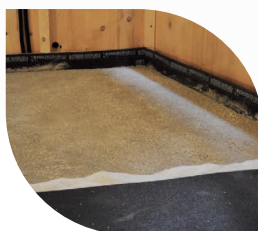
Verlegen von Trittschallmatten
