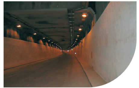
TUNNELVERKLEIDUNG "CIRCONVALLAZIONE NORD" - ROM - ITALIEN
